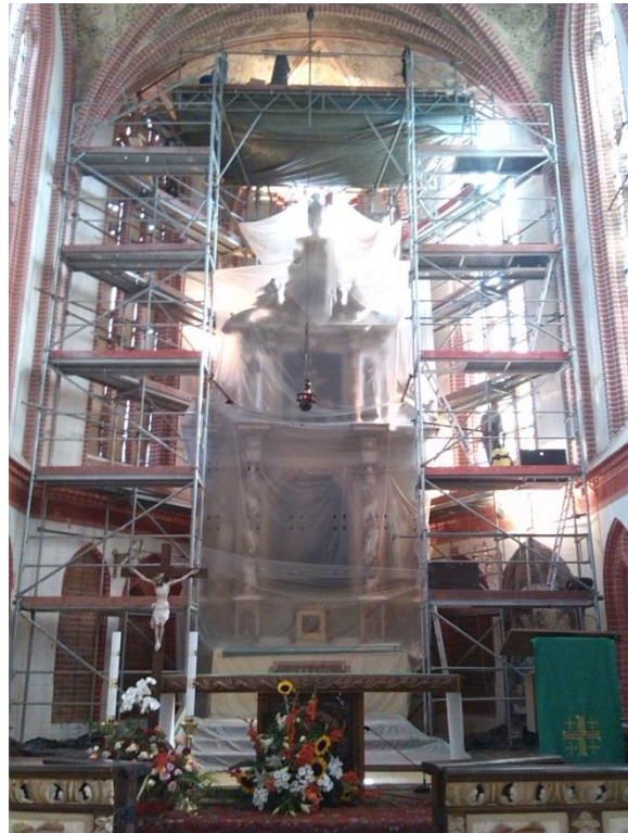
Obrázek 2 Interiér kostela - presbytář s lešením
