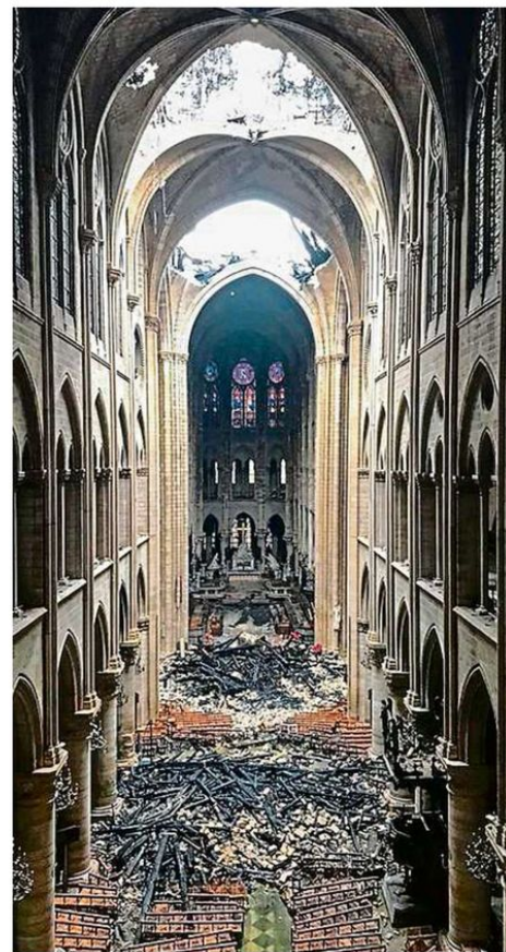
Zkáza i trocha naděje. Snímek z útrobu poničené pařížské katedrály Notre Dame ukazuje, jaké škody napáchal zhavý živel. „S takovým rozsahem poškození nemáme zkušenosti,“ říkájí litomyšlští restaurátoři. FOTO GETTY IMAGES
