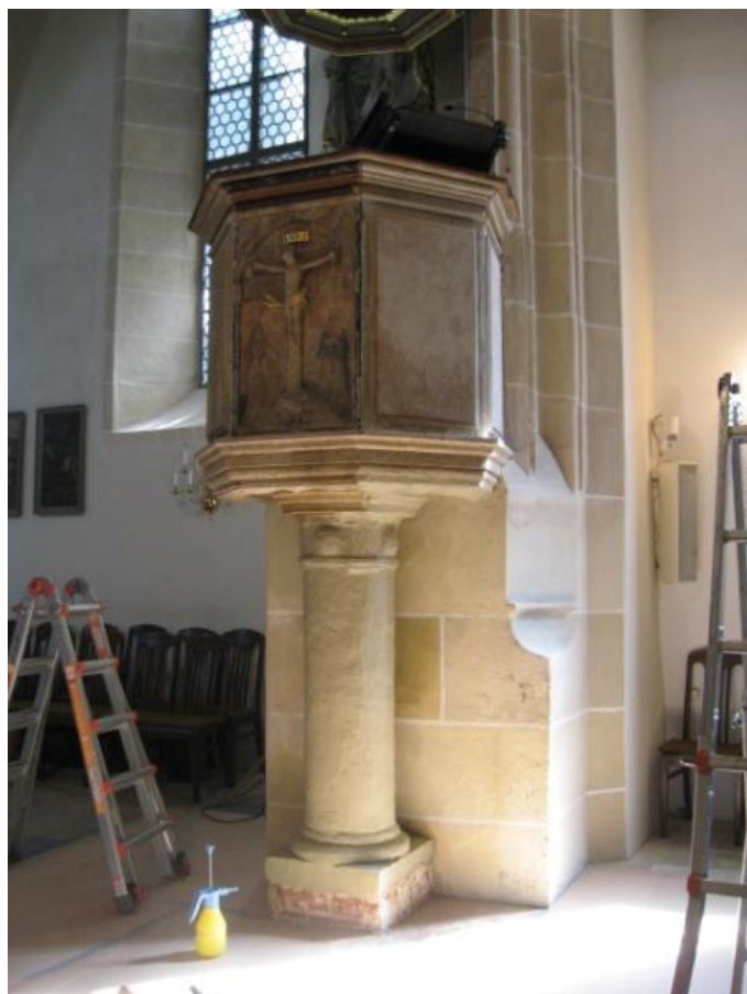
kostel Leubnitz-Neuostra, Drážďany – odsolovací zábal na kazatelně
